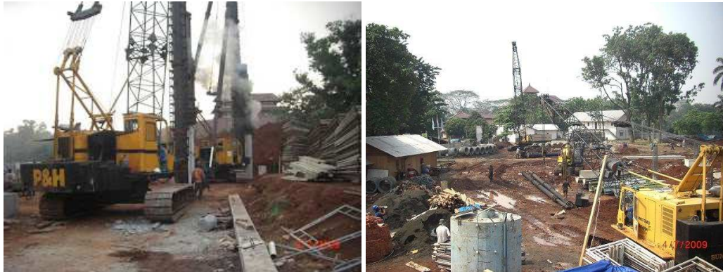
Gambar 1. Pemancangan Tiang Pancang
